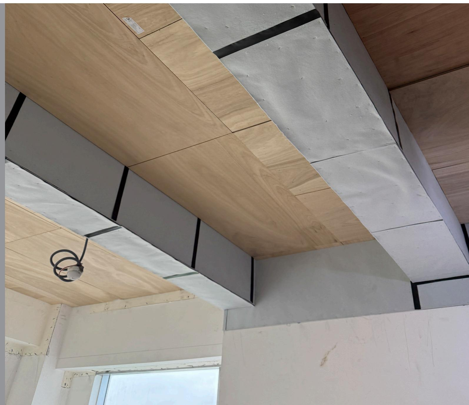
噪音問題往往在入住後才浮現，此時再進行隔音補強，不僅施工更為困難，亦可能增加整體費用與時間成本。選擇在裝修階段進行隔音工程，將 mutie® 隔音板材與結構體結合，不僅施工簡單、不改變整體設計，更能從根本提升空間品質，避免未來為了噪音的問題而感到苦惱。
